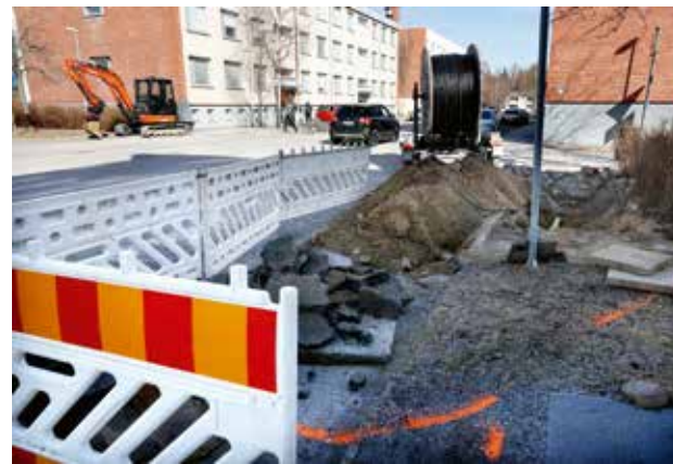
Kaapelityömaa Mikkelissä. Kuva: VESA VUORELA/LÄNSI-SAVO
