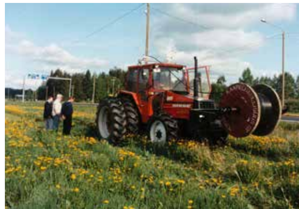
Kaapelityömaa Mikkelin lähistöllä.
